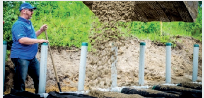
Les piézomètres permettent de mesurer l'hauteur de l'eau à l'intérieur de chaque conduite et s'assurer de la distribution uniforme de l'eau usée.
