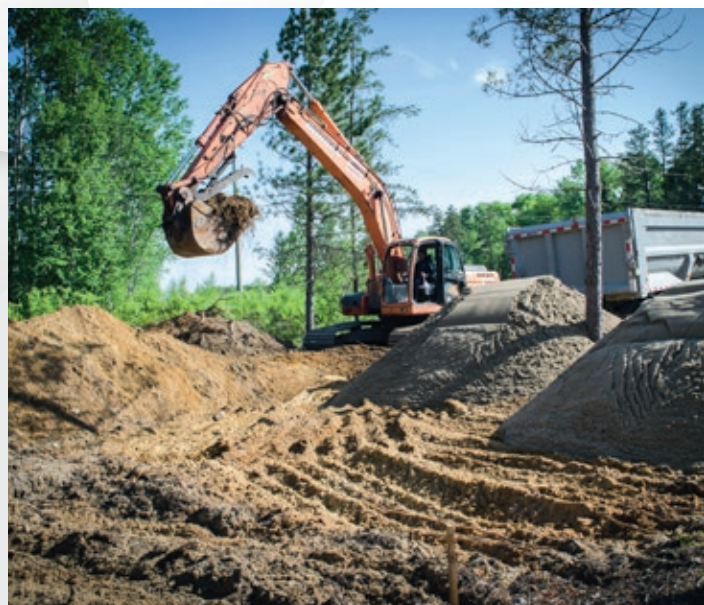
Préparation du terrain
