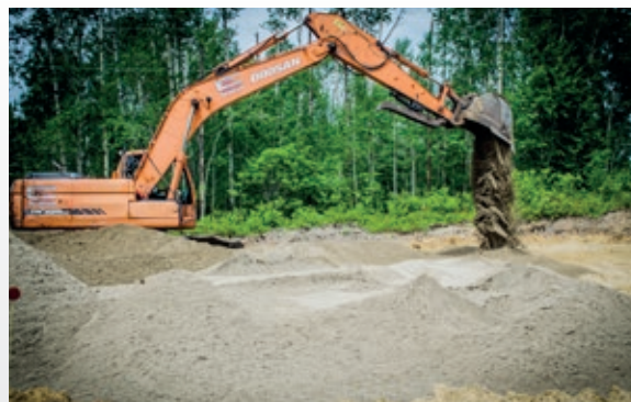
Le sable filtrant est un composant important d'une installation System O))
