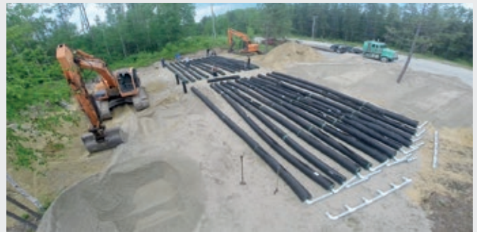
Vue d'ensemble pendant l'installation.
