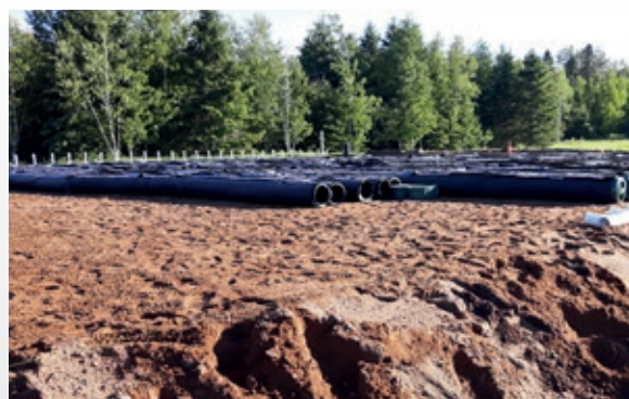
Les conduites Advanced Enviro))Septic sont déposées sur le sable
