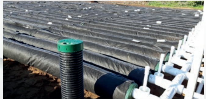
Les injecteurs du système de répartition sous faible pression
