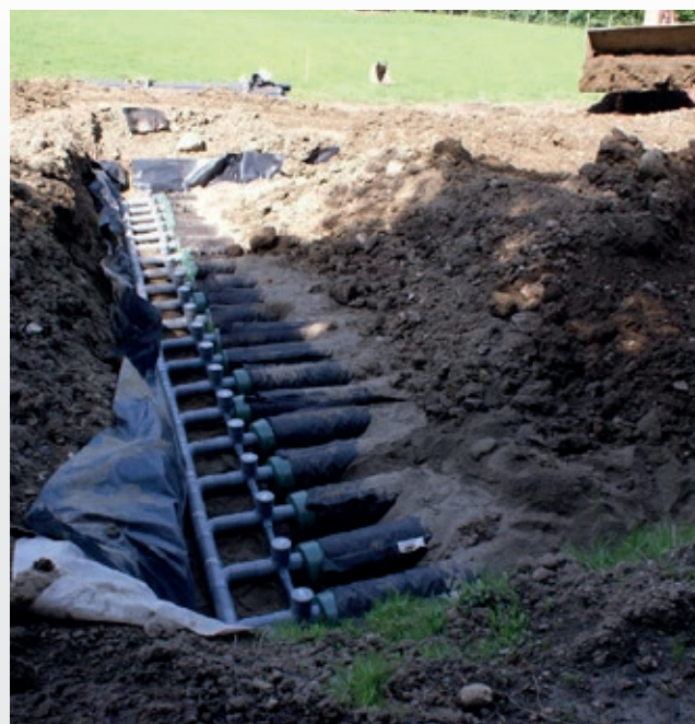
Recouvrir les conduites Advanced Enviro))Septic
